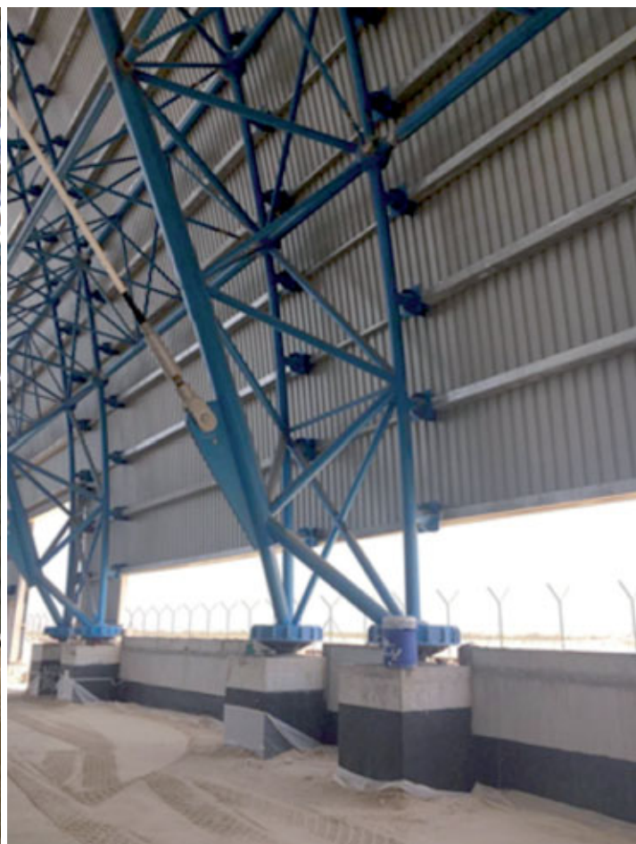
Fig. 10 - Dettaglio dell'imposta degli archi
