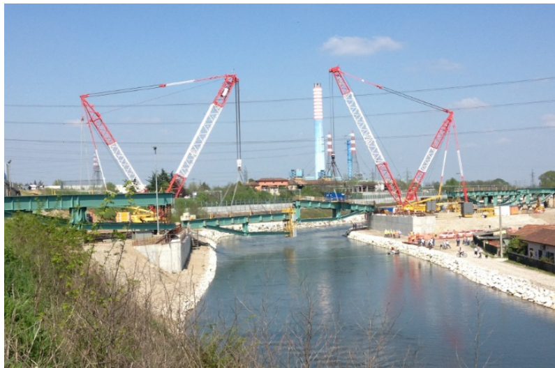
Fig. 5. Varo della struttura metallica sulla carreggiata ovest
