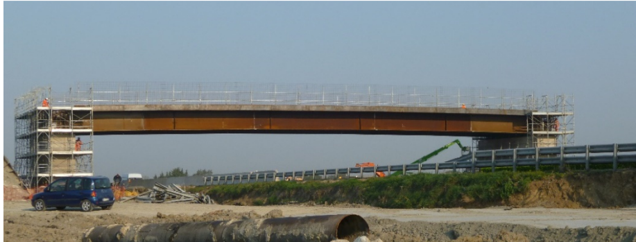
Figura 4 – Vista dell'impalcato varato
