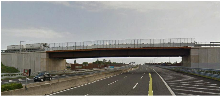
Figura 1 – Vista del cavalcavia dalla carreggiata in direzione sud
