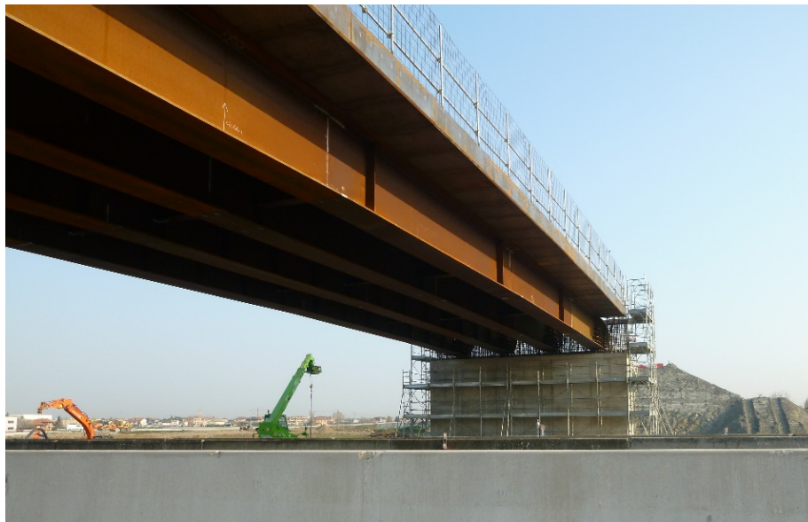
Figura 5 – Ultimazione posa armatura nodo spalla-impalcato
