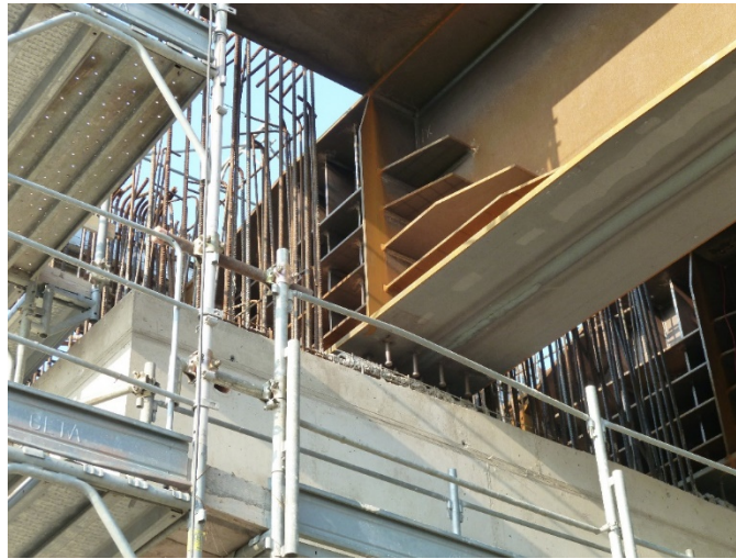
Figura 8 – Ultimazione posa armatura nodo spalla-impalcato
